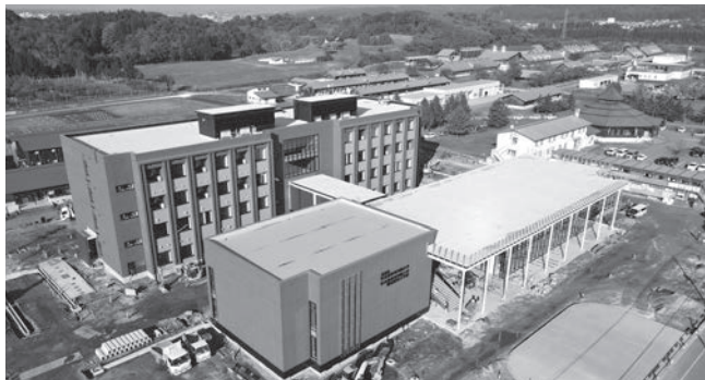
図2. 完成間近の新校舎(令和5年10月30日現在)
