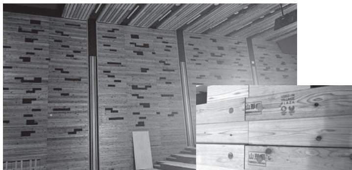
図3. 大講義室の施工状況
