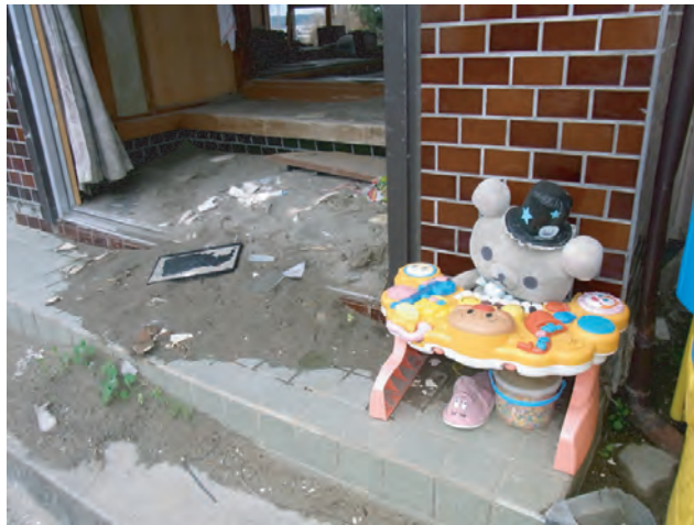
飼い主を待ち続けるリラックマ。飼い主は間違いなく小さな子供。家は全壊しています。
