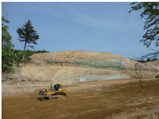
高台への集団移転計画に沿って、近隣の山を開拓する工事もちこちで進んでいます。
