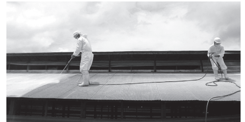
写真2. 屋根へのドロマイト石灰塗布の様子
